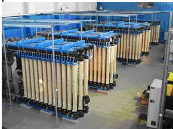
Шесть типовых систем ARIA AP-6 для получения 1000 м 3 /ч питьевой воды из озера (г. Озерск, Челябинская обл., Россия)
