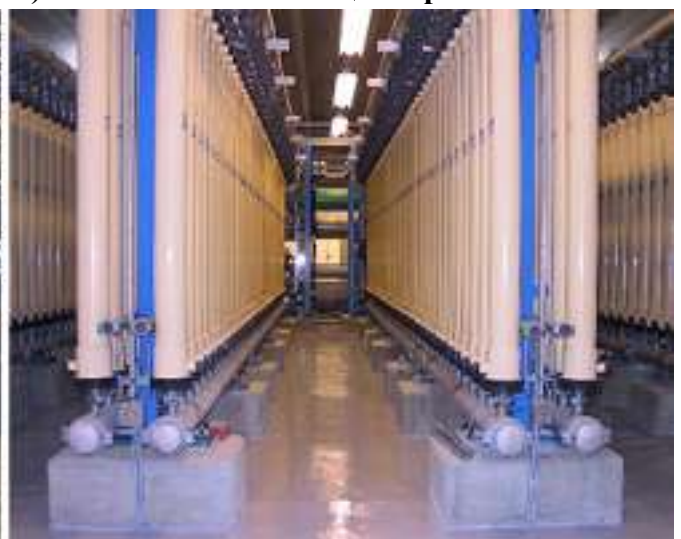
Нетиповая система ARIA для получения 1572 м 3 /ч питьевой воды из поверхностного водоисточника (г. Вестминстер, США)
