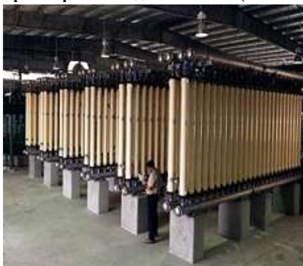
Нетиповая система ARIA для получения 1230 м 3 /ч питьевой воды из речной (г. Сан Патрисио, США)
